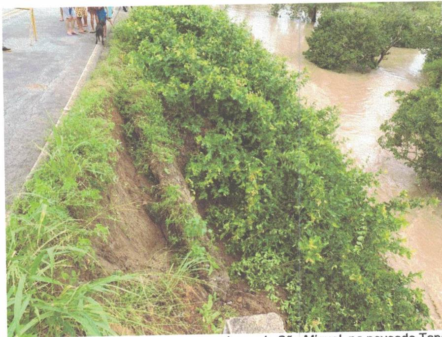
Imagem 13: Parede lateral desabada na ponte sobre o rio São Miguel, no povoado Tapera, AL-450
